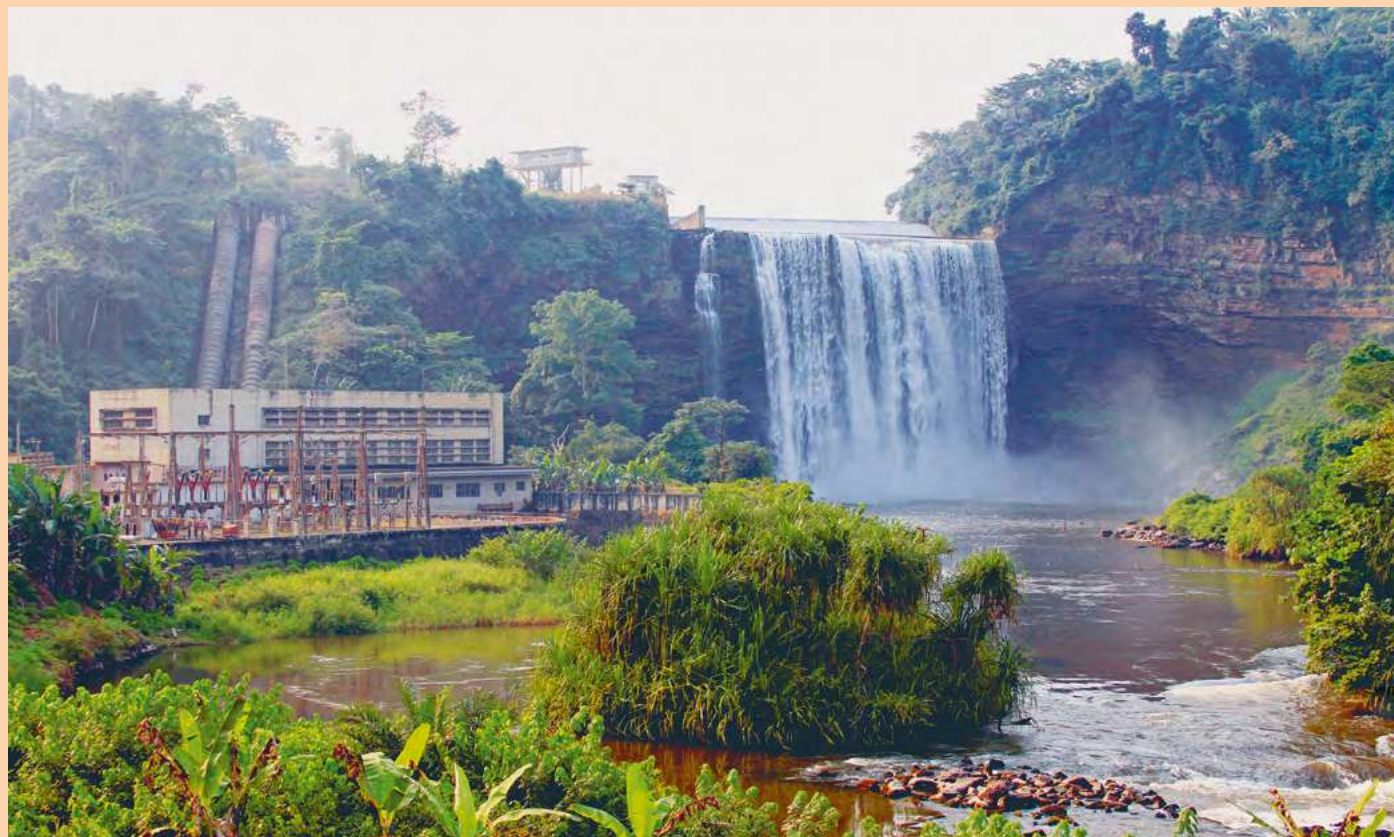
MOUKOUKOULOU Le barrage hydroélectrique
