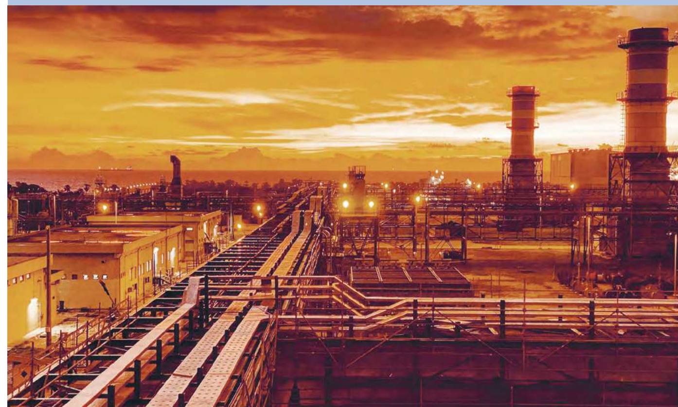
CONGO Centrale électrique de Côte Matève
